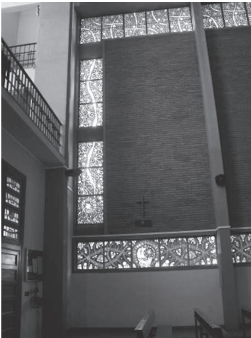
Fig. 7. Vidrieras de la nave
