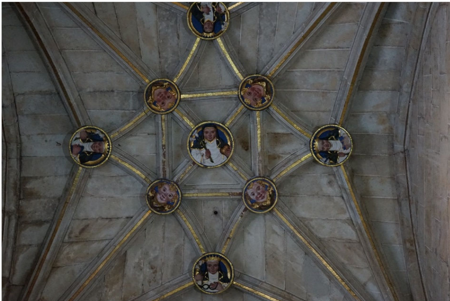
Fig. 3. Detalle de las claves de bóveda de la capilla de las Reliquias en San Esteban de Salamanca. Fotografía del autor.
