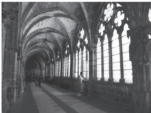
Vista actual del claustro alto
