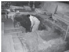
Trabajos realizados en el presbiterio
