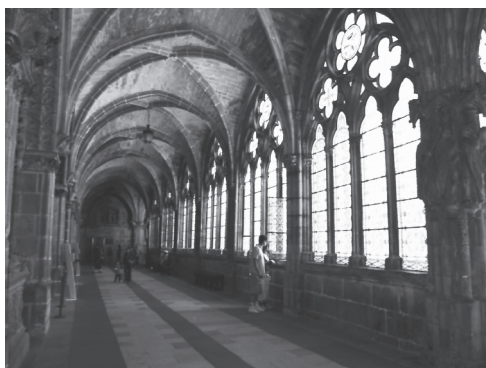
Vista actual del claustro alto
